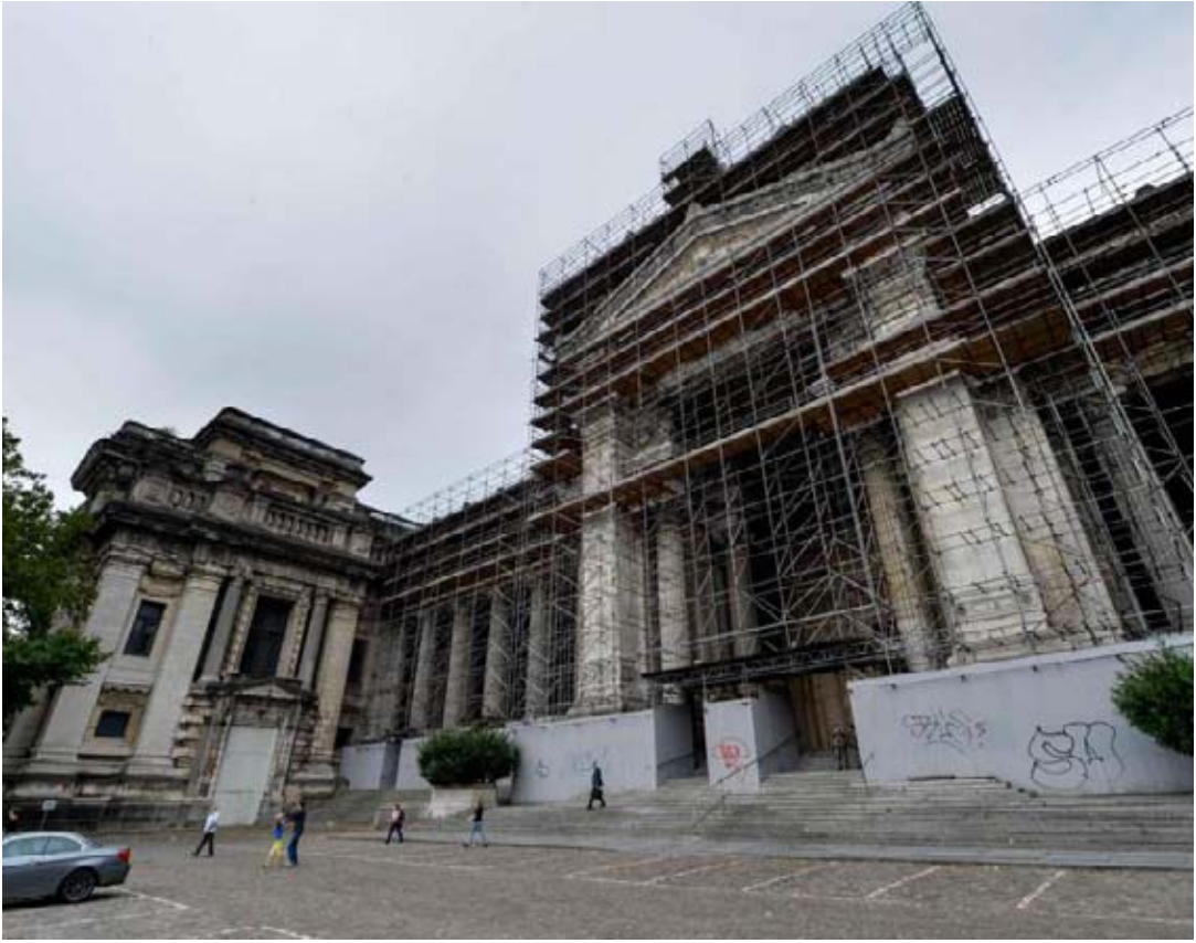
La façade de la place Poelaert devrait être rénovée en 2021. © PIERRE-YVES THIENPONT.
