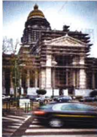
Les échafaudages ont eux-mêmes été rénovés en 2009.
